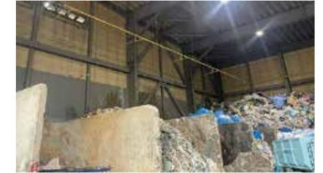
荷受け工場及び土間選別場の廃棄物ピット上部に設置してあるスプリンクラーノズルへの接触防止のため、ノズルを黄色く塗る処置を行った。
