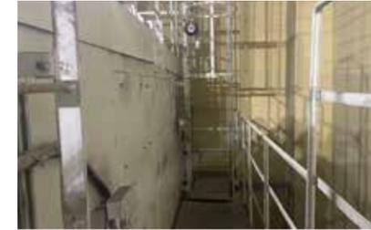
工事業者による焼却炉棟はしごの墜落事故の再発防止策として、安全帯であるベルブロックの設置、はしごの途中段階で鉄板を敷き、穴を塞ぐ処置を行った。
