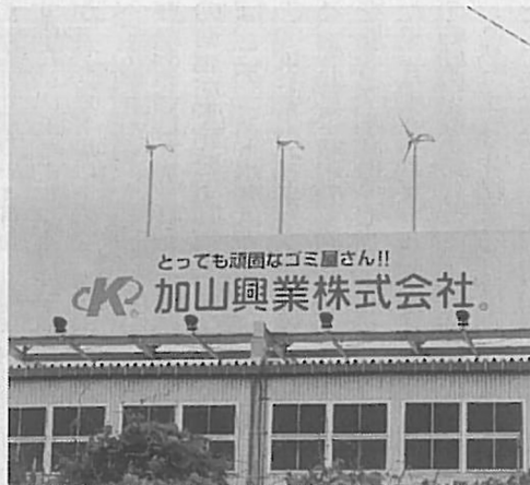
屋上に看板と共に風車を設置
